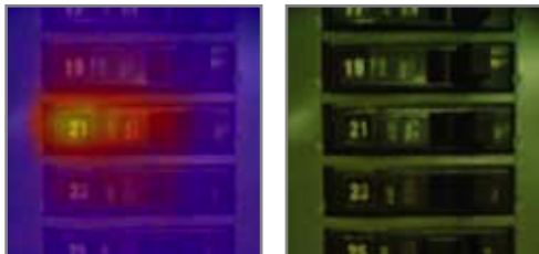
Перегруженные автоматические выключатели
