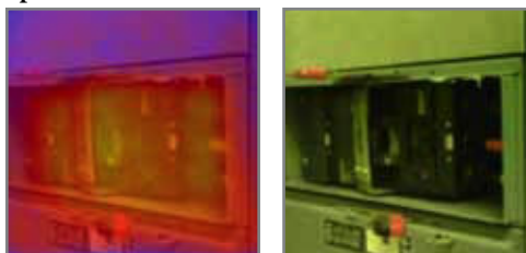
Отслеживание нормальной рабочей температуры критически важного выключателя
